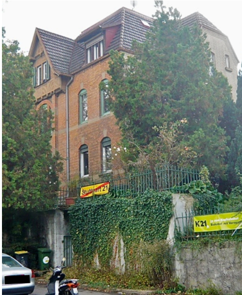
Tunnelstr. 20 ist durch den Tunnelbau gefährdet.
